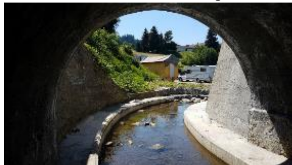
Unteres Portal nach Instandsetzung:
