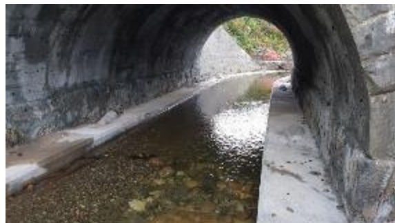
Durchlass nach Instandsetzung:
